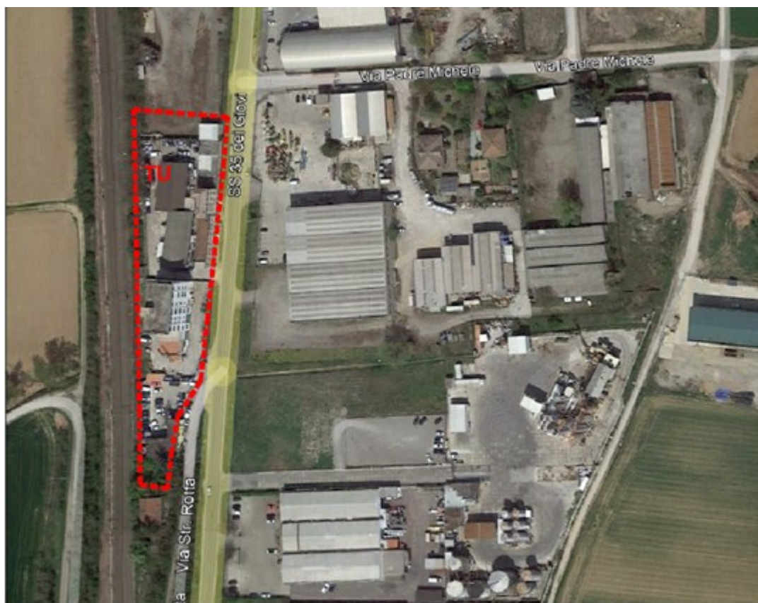
Area D1 dismessa
